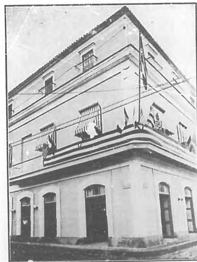
LAS NUEVAS OFICINAS DE CORREOS Y TELEGRAFOS DE SANTA CLARA. —Fachada del edificio que ocupan los Departamentos de Correos y Telégrafos.
